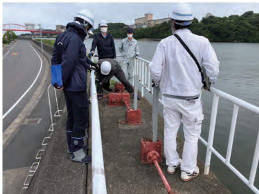
新川水門：ゲート稼働
