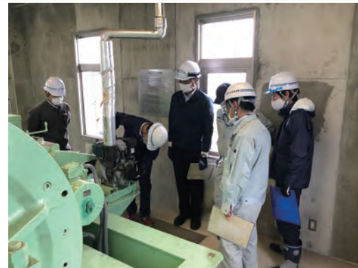
機械室：操作確認
